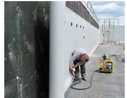
Blockiert wie hier ein Geländer die Mauerkrone, kann das Abdichtsystem auch von Hand eingebaut werden.
