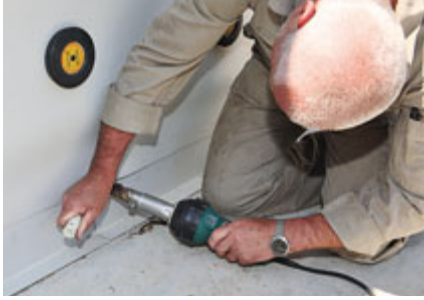
Bei kleineren Siloanlagen lässt sich die Plane auch manuell mit einem Heißluftföhn verkleben bzw. einbauen.
